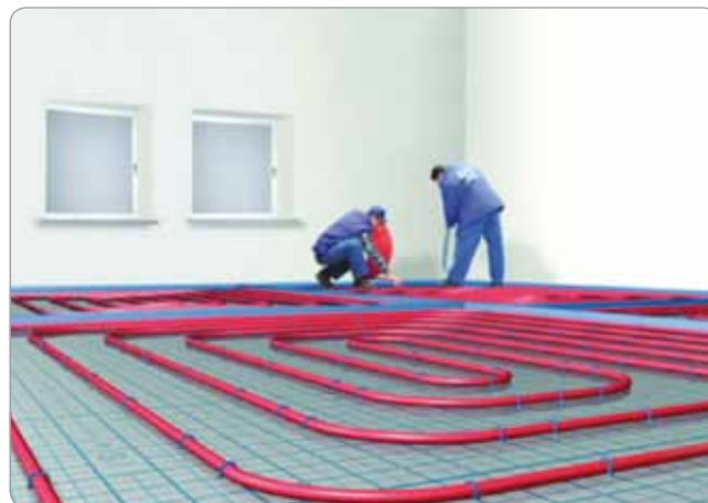
Obr. 3 Příklad podlahového vytápění [2]
